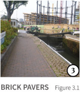
BRICK PAVERS Figure 3.1 Colour: Red Dim.: 65 x 102.5 x 215mm Mortar: 6 mm
