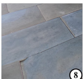
YORK STONE PAVING Dim.: 80 x 200 x 300 mm Mortar: 6 mm
